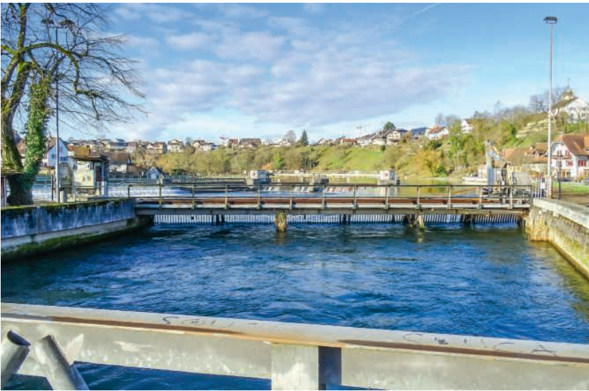
Das Axpo-Kleinkraftwerk braucht eine hindernisfreie Fischpassage
